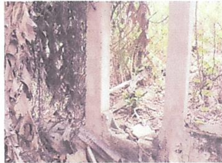
Foto 6: Sustitucion de la maya y parte del muro que circula la escuela ya que tiene oyes y no es seguro para el Establecimiento
