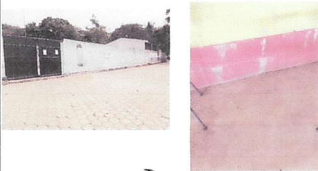
Foto 5: Sustitucion de pintura del interiores de las aulas y del exterior de la escuela.
