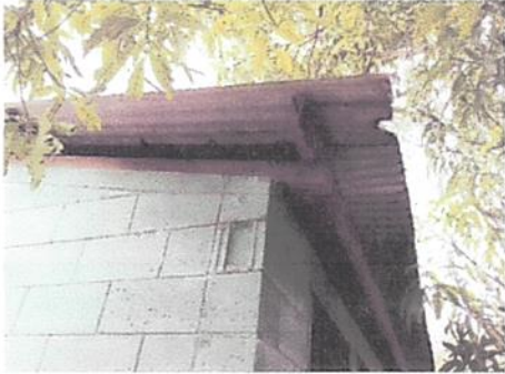
Foto 1: sustitucion de lámina ya que se encuentra deteriorada
